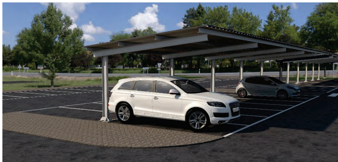
Acabados: Pilares, vigas y correas en acero galvanizado en caliente por inmersión Calidad del acero S275 Tornillería A2/70 Opción con chapa: Cubierta de chapa metálica prelacada color blanco pirineo
